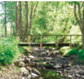
Brücke über die Horstbach.
