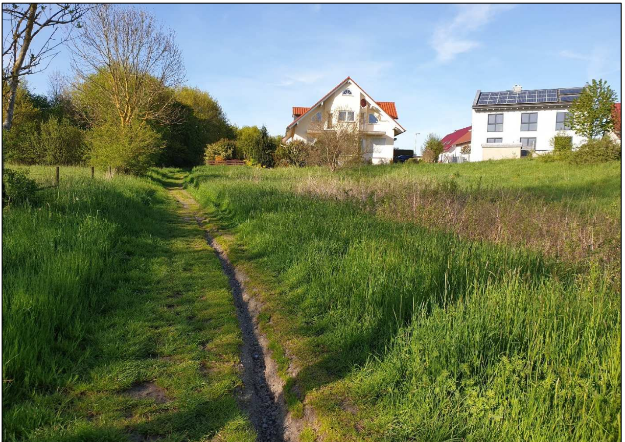
Abb. 19: Feldweg im Nordosten mit Erosionsspuren
